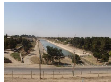
Рис.5. Правый сбросной канал
